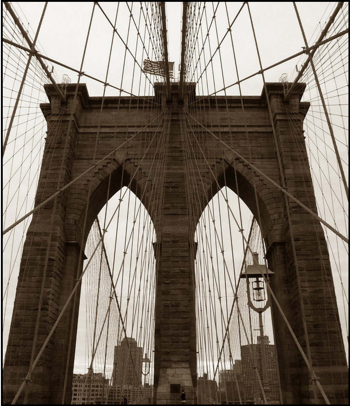
121.- Brooklyn Bridge - 19 de Octubre del 2002
