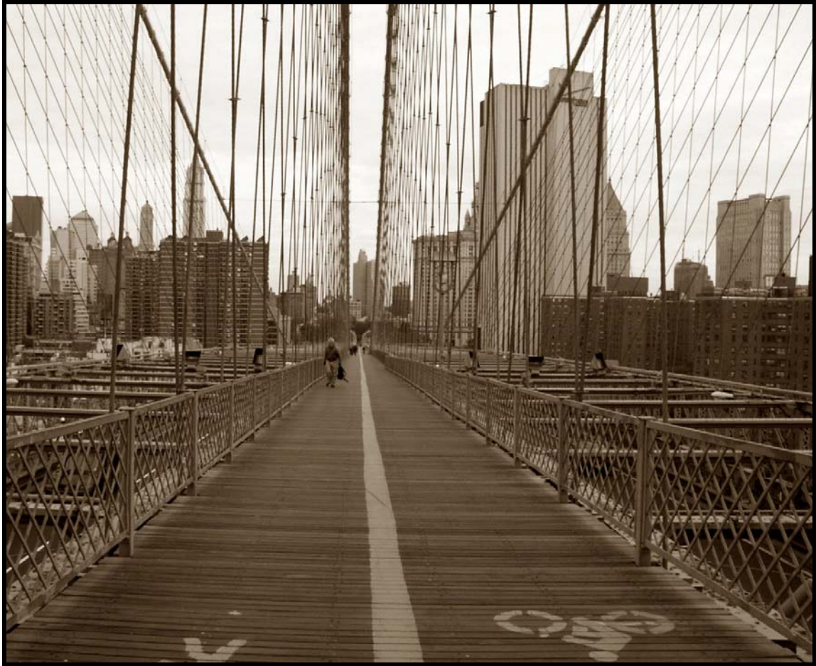
100.- Brooklyn Bridge - 19 de Octubre del 2002
