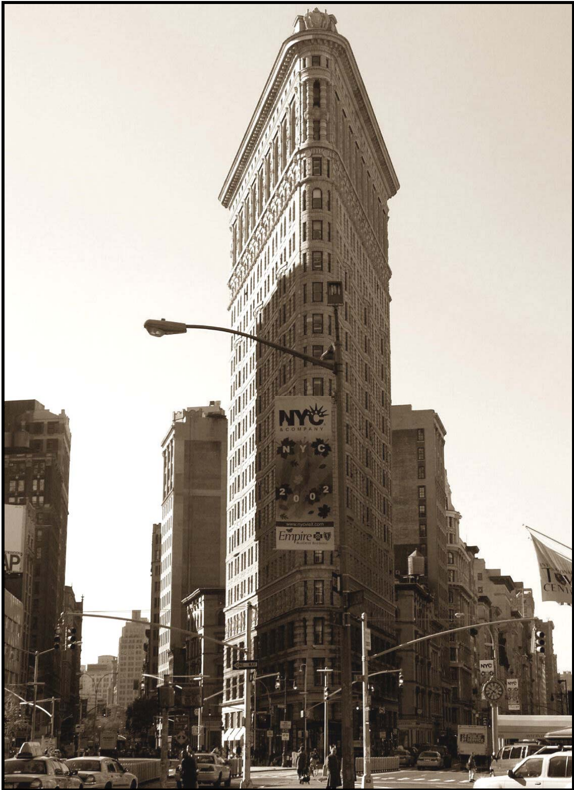
114.- Flatiron Building - 18 de Octubre del 2002
