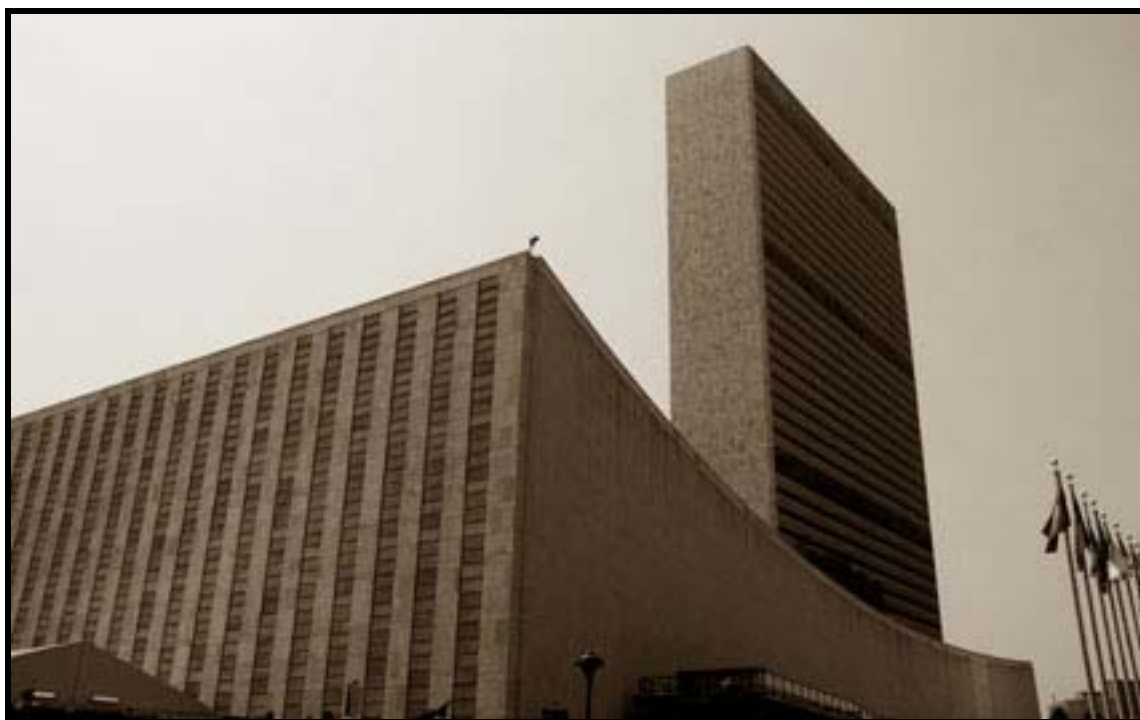
179.- Edificio de las Naciones Unidas - 24 de Junio del 2004
