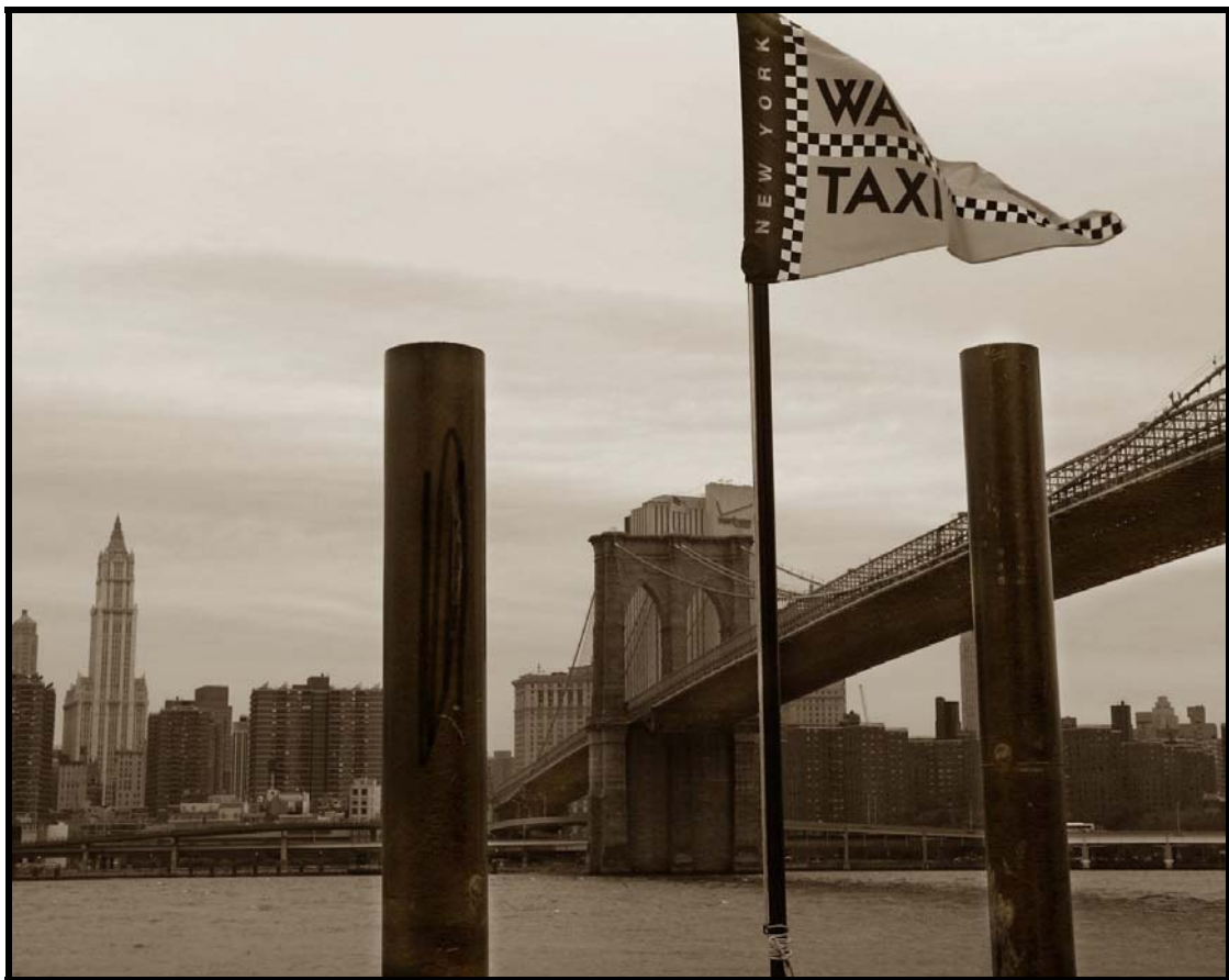
12.- Vista del Brooklyn Bridge desde Brooklyn – 19 de Octubre del 2002
